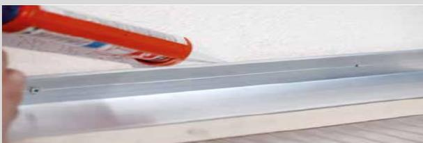
Die Wandanschlußprofile können mit dauerelastischem Kautschuk an der Wand abgedichtet werden.
