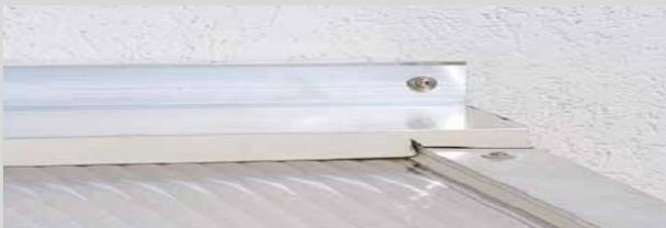
Für Dächer, die an Hauswände anschließen gibt es geeignete Wandanschlussprofile, die an die Hauswand angeschraubt werden. Die Dichtlippen dieser Profile werden an den Profilen eingeschnitten.
